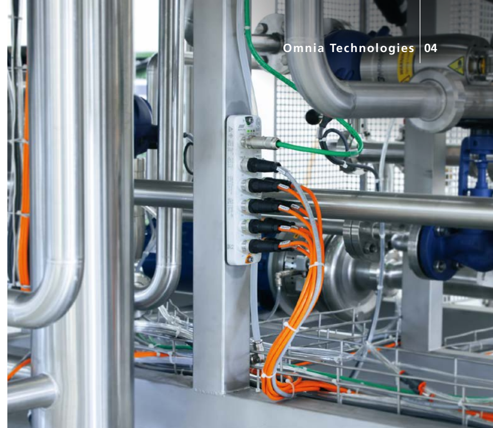
Il master IO-Link da campo raccoglie i dati dei sensori in modo decentralizzato e li trasmette al sistema di controllo.
