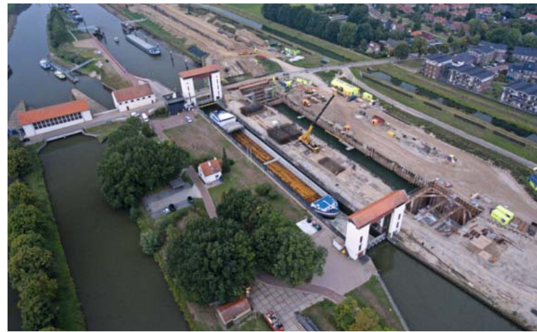
Die Schleuse in Eefde (Niederlande) wurde 1933 erbaut und wird gerade um eine weitere Schleusenkammer erweitert.
