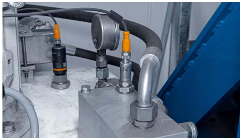
*Überwachung des Hydraulikaggregats auf Druck, Ölfüllstand und -temperatur.*
