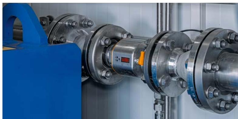
*Zentraler Messwert: Ein magnetisch-induktiver Durchflusssensor überwacht die Klärschlammmenge, die in die Zentrifuge gelangt.*
