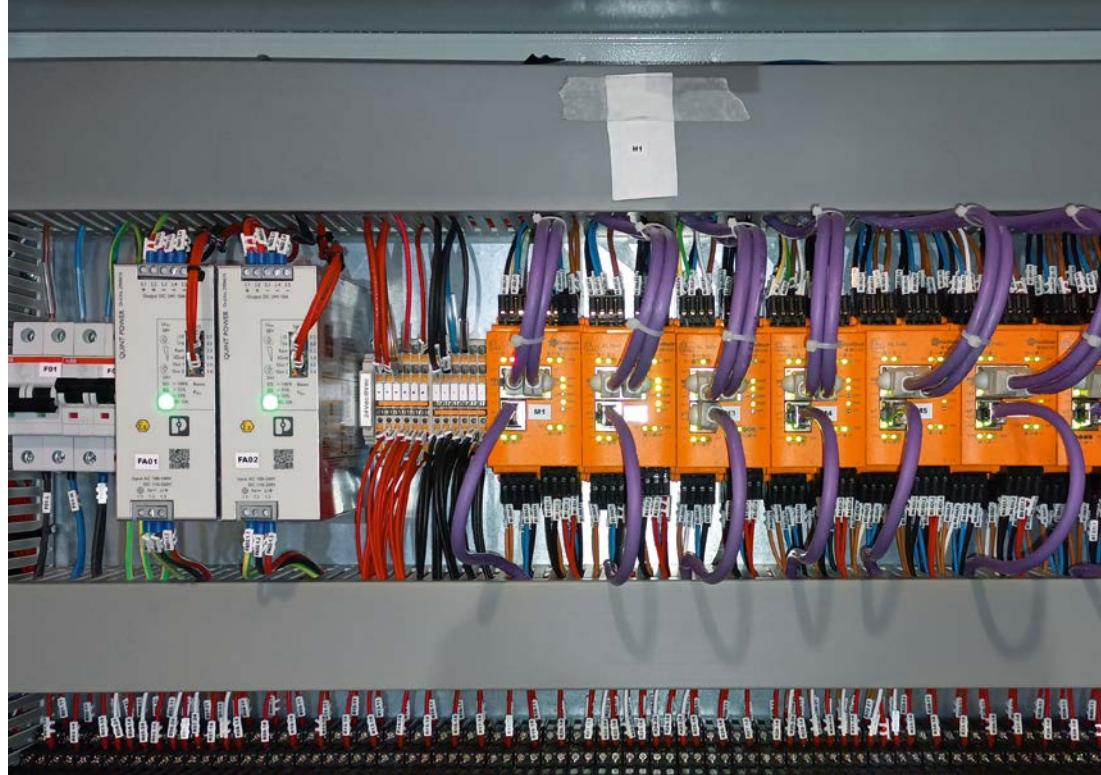
*Los maestros IO-Link y las unidades de evaluación para sensores de vibración recopilan los datos y los transmiten agrupados al nivel de IT.*
