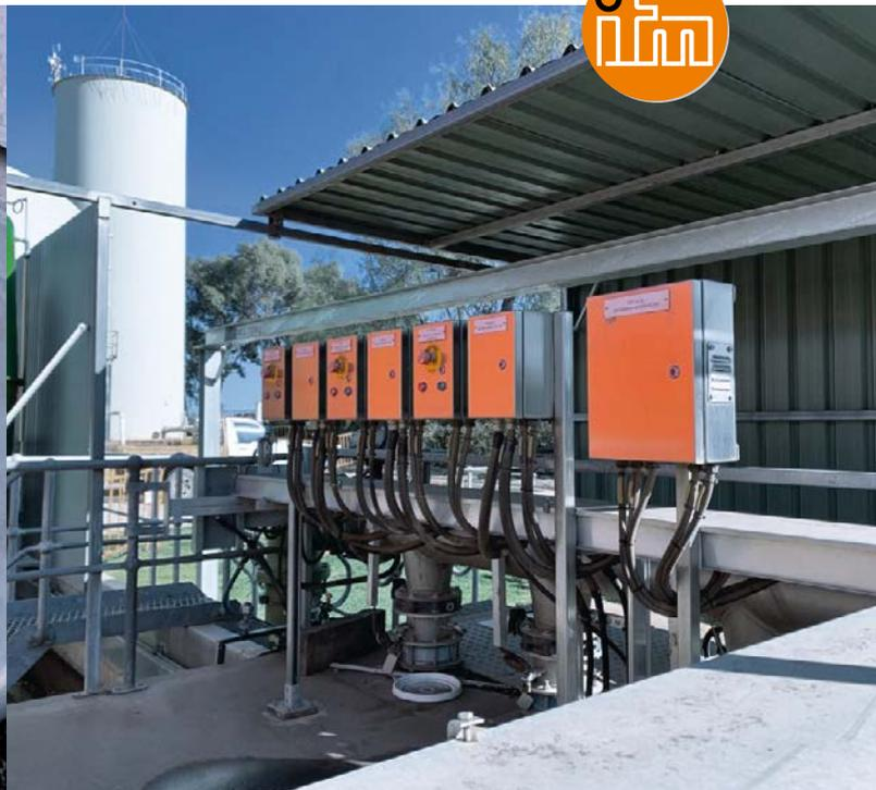
Der MVQ101 sorgt für eine zuverlässige Trennung zwischen Trink- und Brauchwasser. Der Sensor erkennt selbst kleinste Ventilöffnungen von nur 0,1 Grad.
