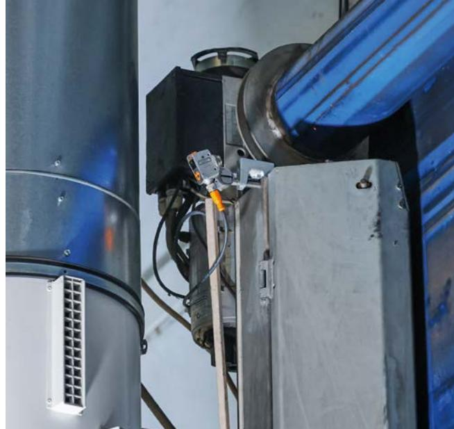
Un sensor fotoeléctrico comprueba si la puerta está abierta o cerrada.
