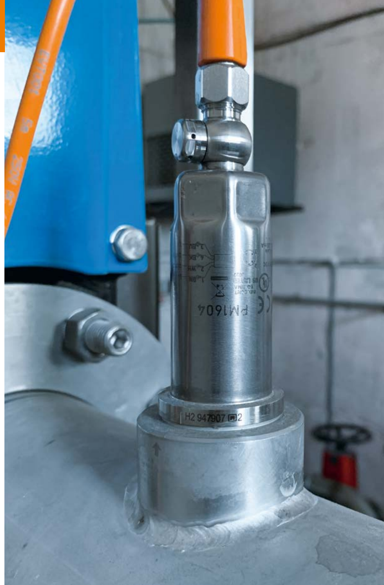
Der ifm-Drucksensor PM1604 ist mit seiner robusten keramisch-kapazitiven Druckmesszelle ideal für die Überwachung der Pumpe geeignet.
