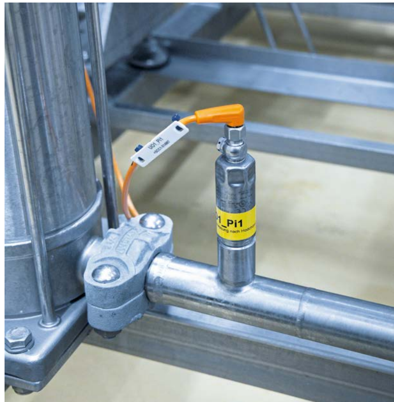
Ideal für kleine Nennweiten: Drucksensor der Baureihe PM15 mit G \frac{1}{2} -Prozessanschluss in der Beschickung der Umkehrosmoseanlage.
