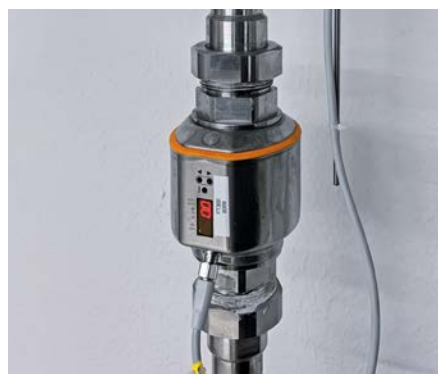
Der Durchflussensor überträgt gleich mehrere Messwerte per IO-Link an die Steuerung.
