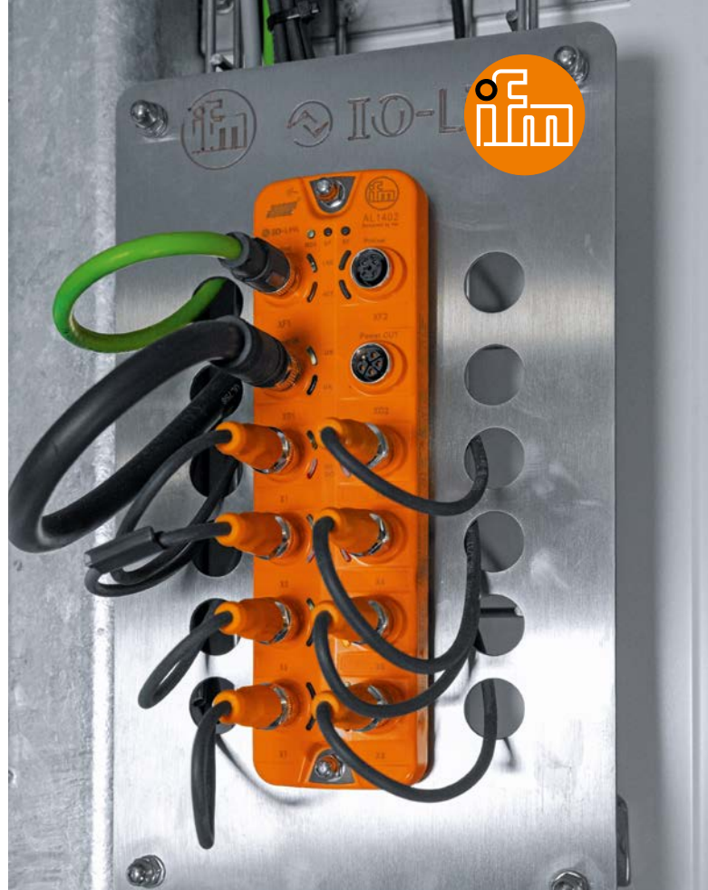
Einfach aufschrauben statt umständlich verdrahten: Alle Sensoren sind mit dem IO-Link-Master verbunden, welcher die Signale per Profinet an die Anlagensteuerung weiterleitet.
