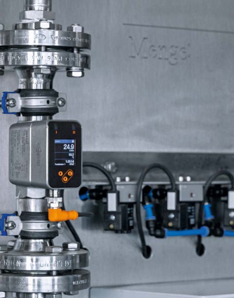
Verschiedenartige Durchflusssensoren helfen bei der Dosierung des Flockungsmittels.
