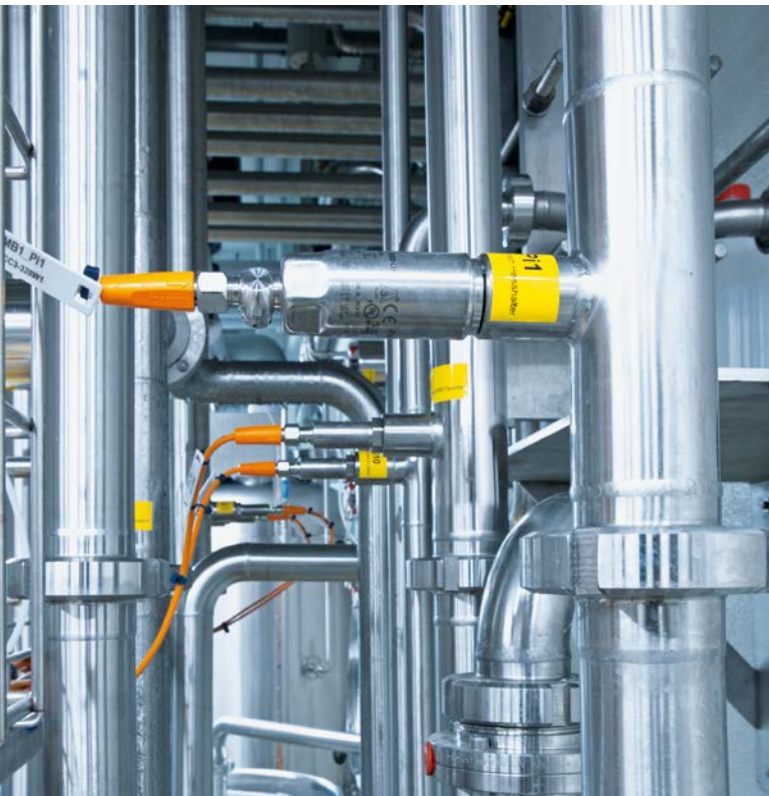
Kompakt und hygienetauglich: Drucksensor der Baureihe PM15 mit frontbündiger Keramik-Messzelle.
