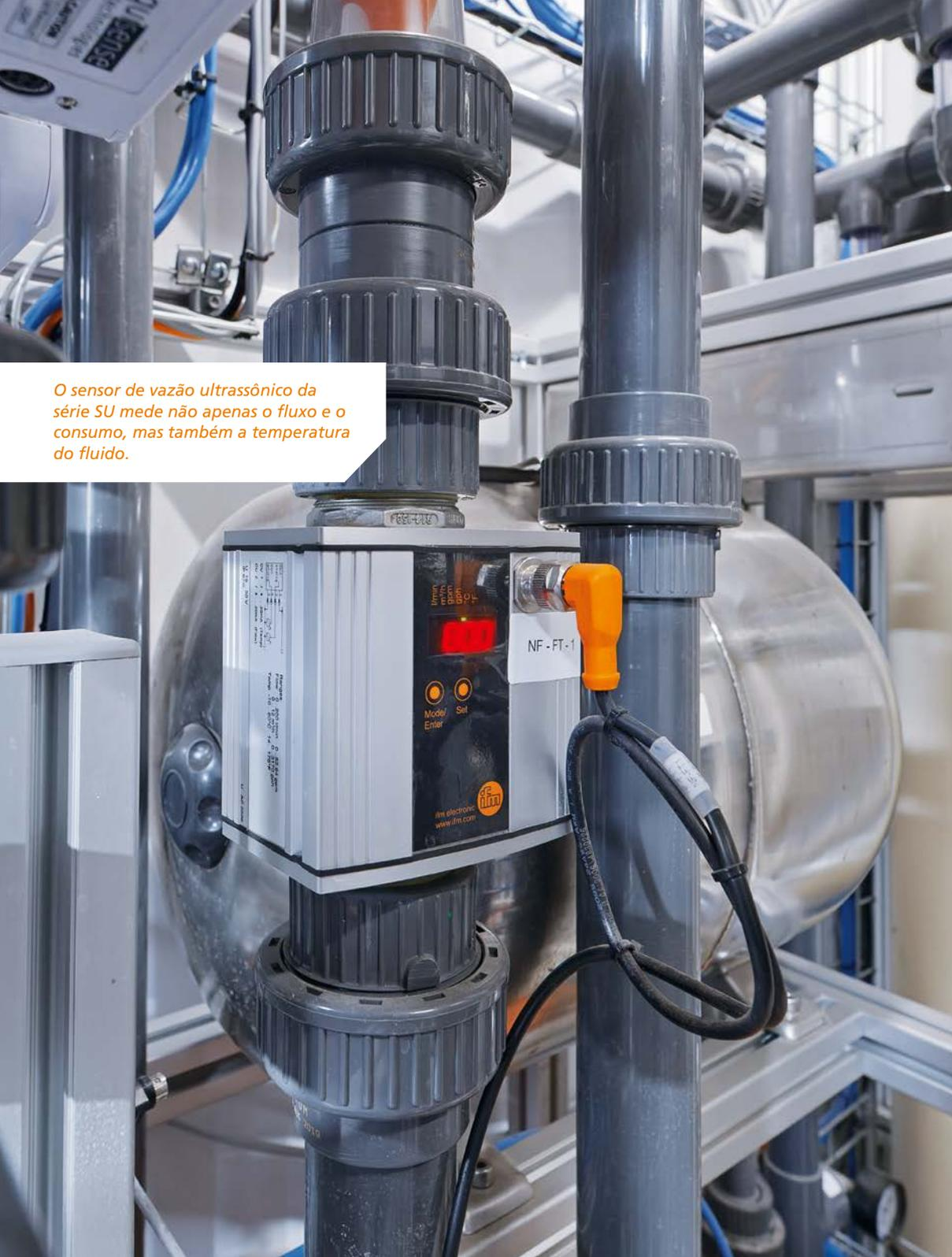
O sensor de vazão ultrassônico da série SU mede não apenas o fluxo e o consumo, mas também a temperatura do fluido.
