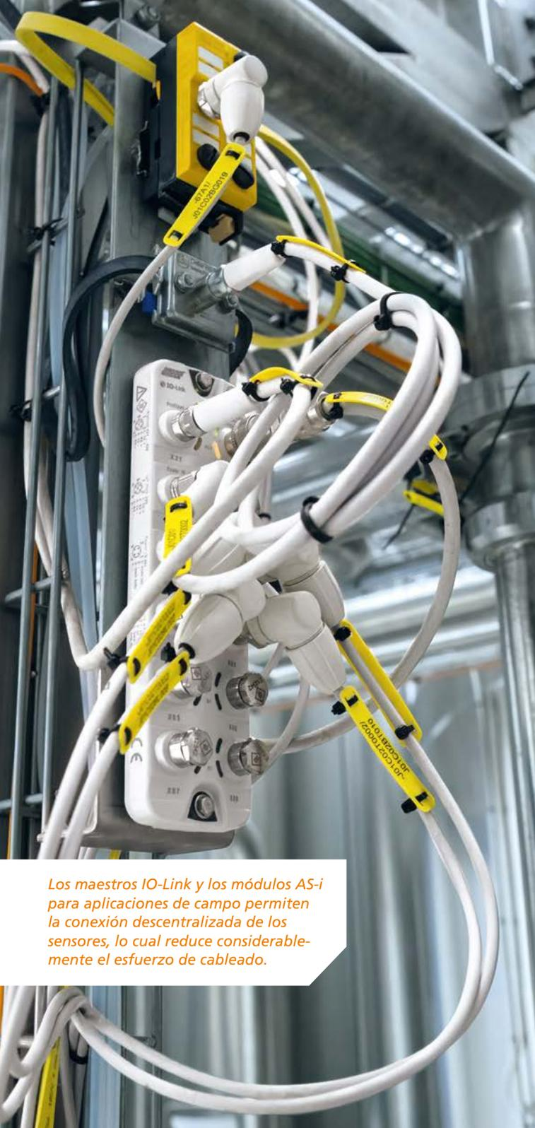
Los maestros IO-Link y los módulos AS-i para aplicaciones de campo permiten la conexión descentralizada de los sensores, lo cual reduce considerablemente el esfuerzo de cableado.
