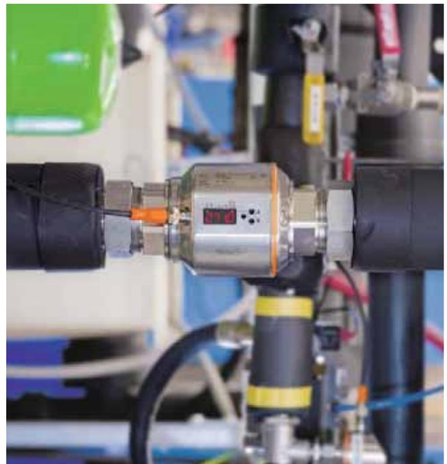
电磁感应式体积流量传感器，用于测量过滤系统中的水量。
