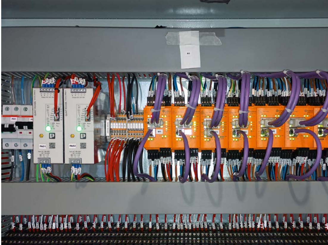
IO-Linkマスタと診断ユニットで振動データを収集しITレベルへ一括伝送
