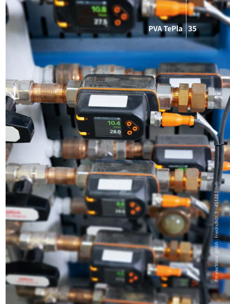
視認性に優れたディスプレイ付き流量センサ： 拡散接合炉の冷却ラインを安定監視します。
