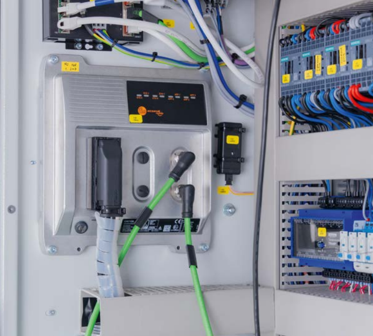
CR710S 중앙 모바일 컨트롤 장치는 일반 PLC와 독립적으로 작동하는 두 번째 안전 PLC를 모두 갖추고 있습니다.
