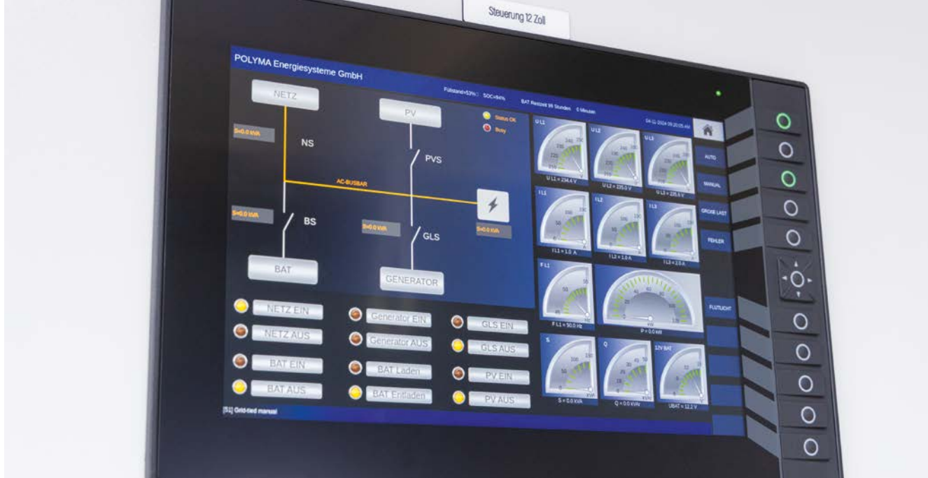
중앙의 ifm CR1204 터치 디스플레이는 모든 작동 파라미터를 시각화하고, 다양한 기능을 세팅하는 데 사용됩니다.
