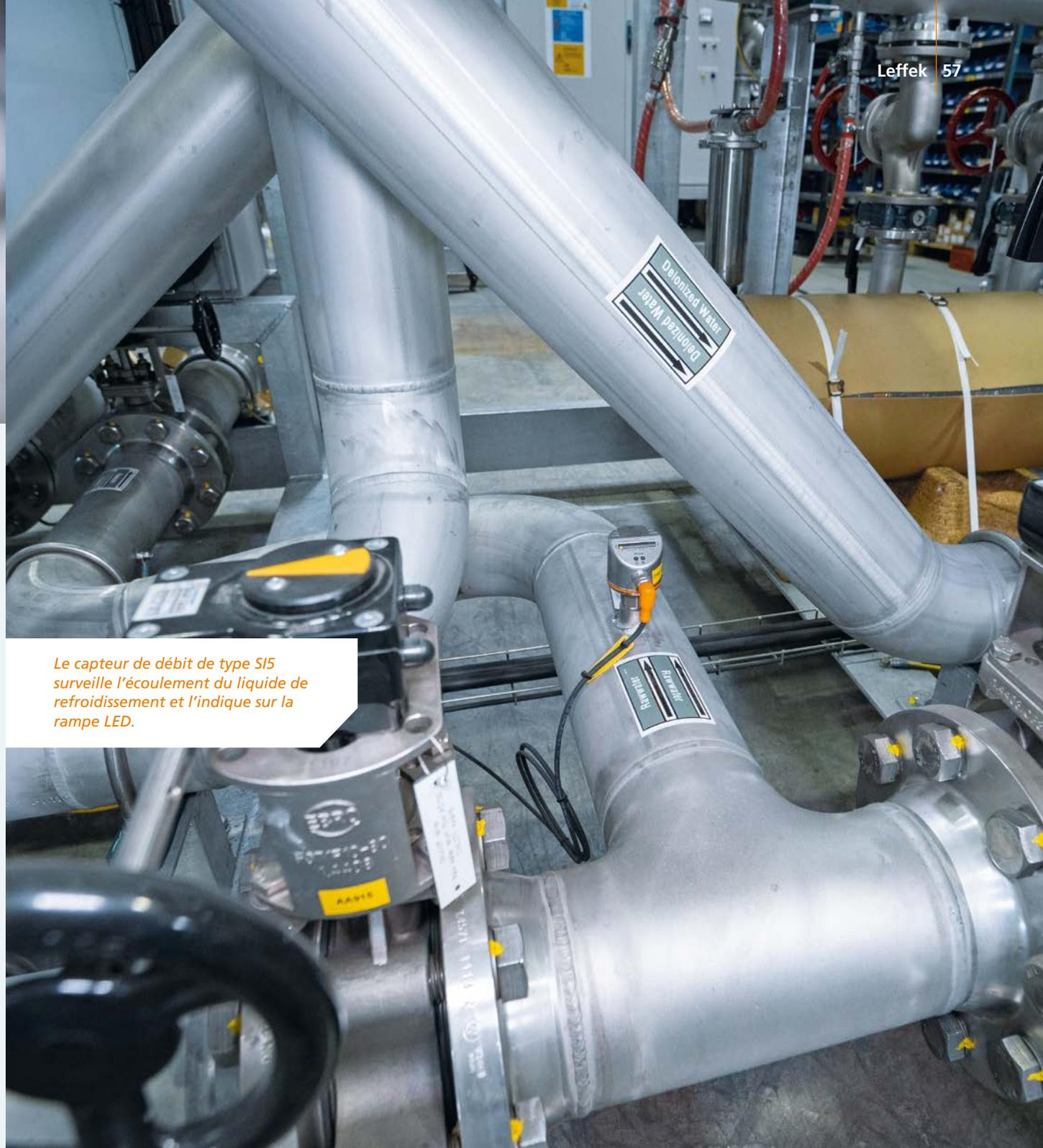
*Le capteur de débit de type SI5 surveille l'écoulement du liquide de refroidissement et l'indique sur la rampe LED.*
