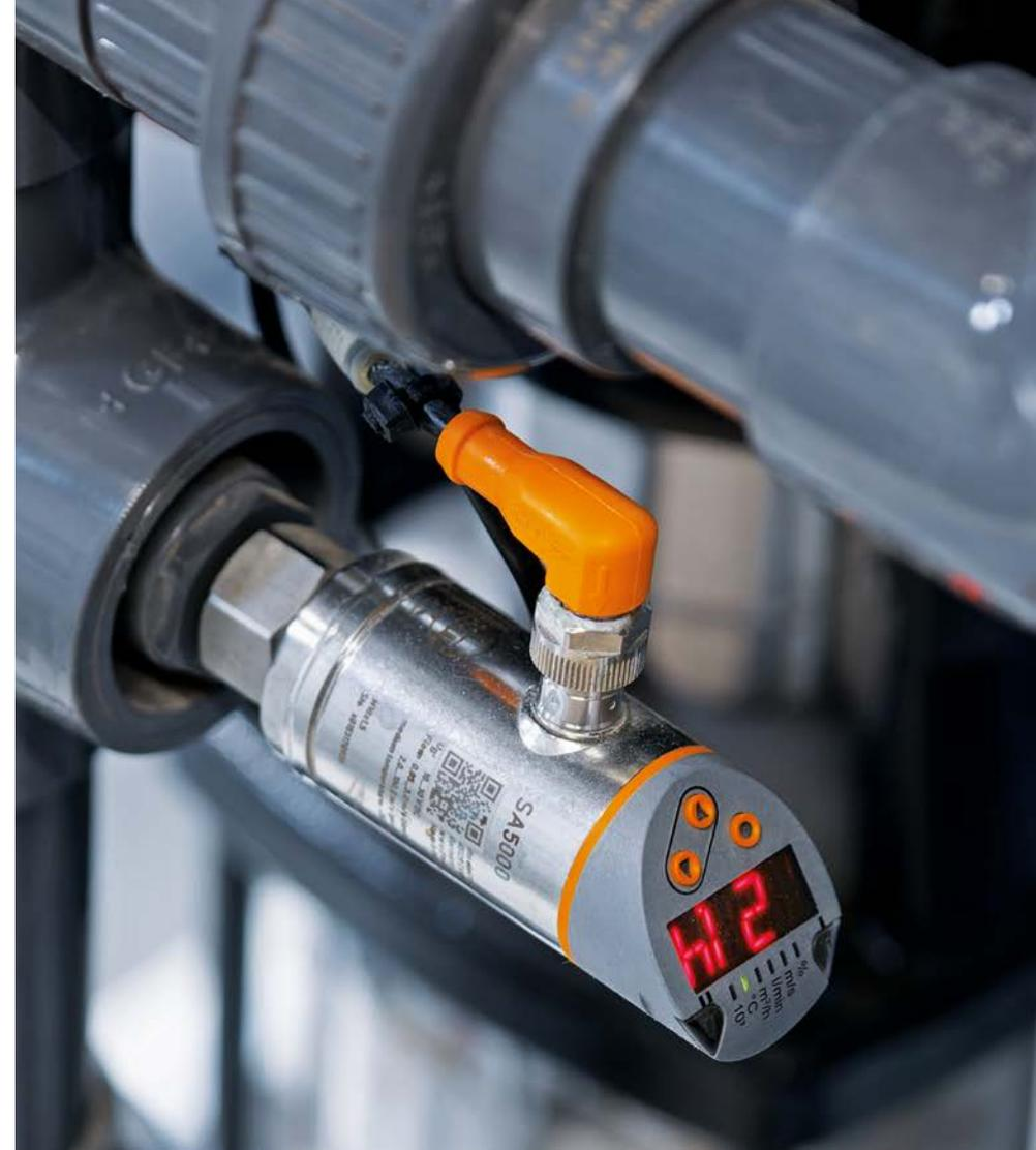
*Le capteur de débit SA5000 permet la mesure simultanée du débit et de la température.*
