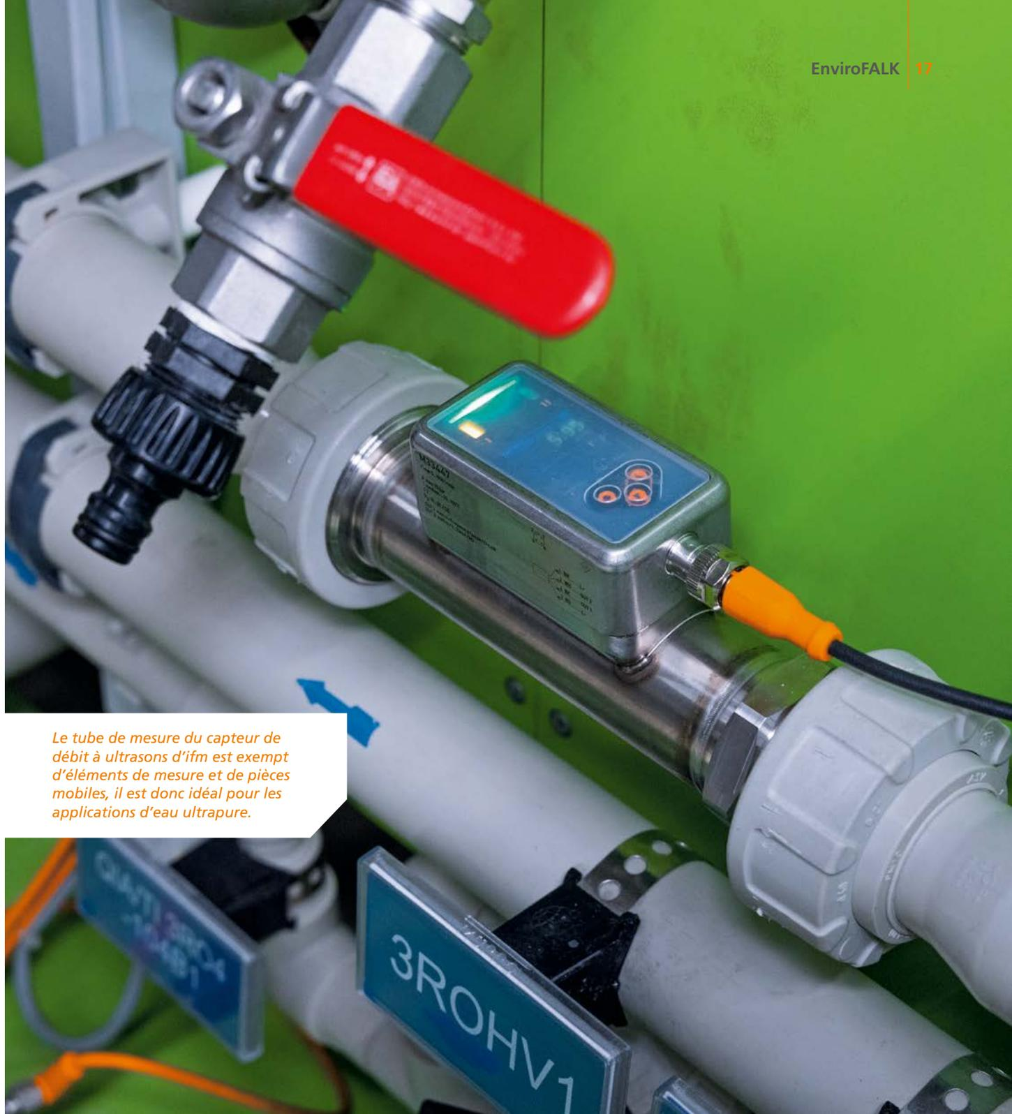
*Le tube de mesure du capteur de débit à ultrasons d'ifm est exempt d'éléments de mesure et de pièces mobiles, il est donc idéal pour les applications d'eau ultrapure.*
