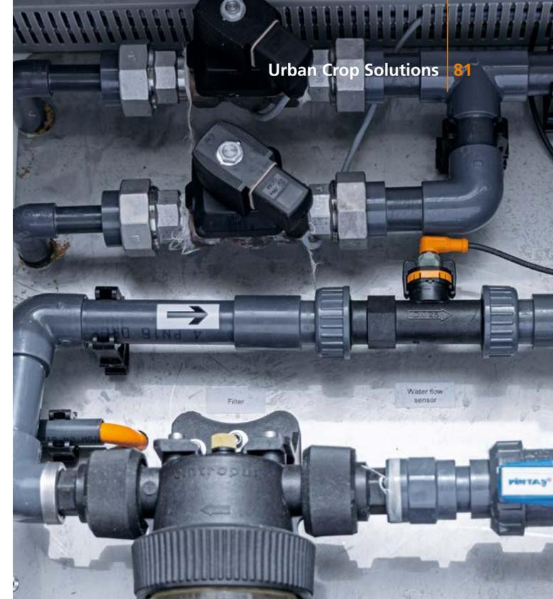
Le niveau, la température et le débit sont surveillés par des capteurs ifm – trois facteurs déterminants pour la qualité des plantes.
