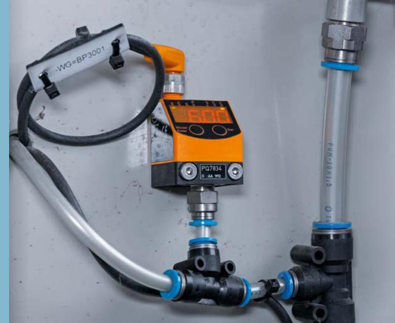
Un capteur de pression de la série PQ surveille la pression d'air nécessaire pour actionner les vannes.
