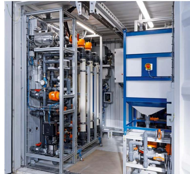
Die komplette Wasseraufbereitung ist in einem kompakten Container integriert.
