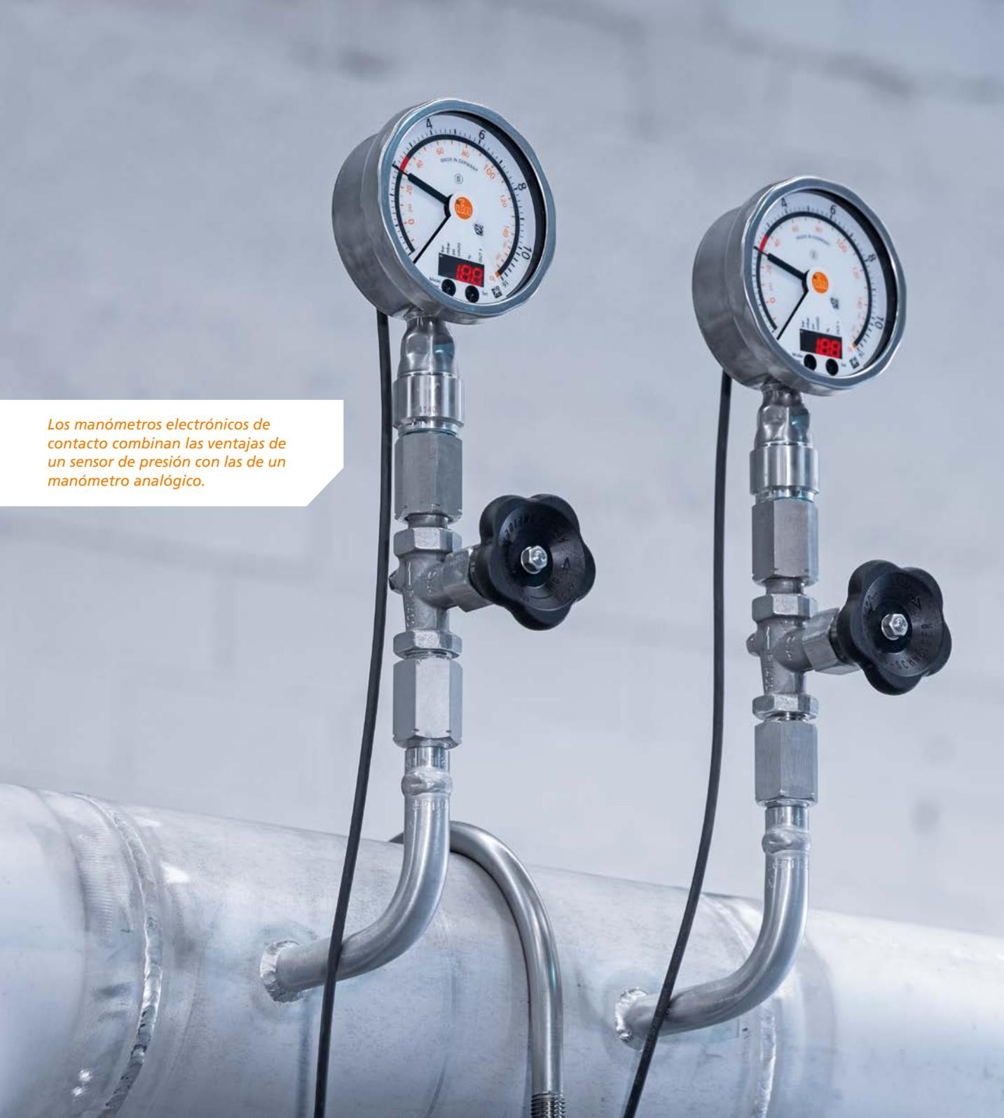
Los manómetros electrónicos de contacto combinan las ventajas de un sensor de presión con las de un manómetro analógico.
