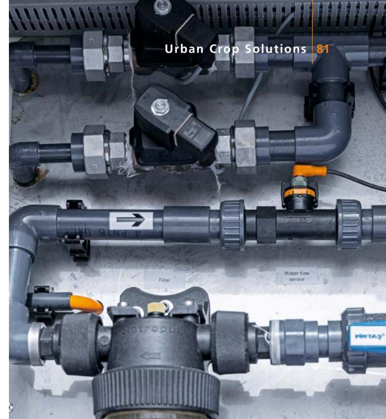
*Füllstand, Temperatur und Durchfluss werden von ifm-Sensoren überwacht – drei Faktoren, die über die Qualität der Pflanzen entscheiden.*
