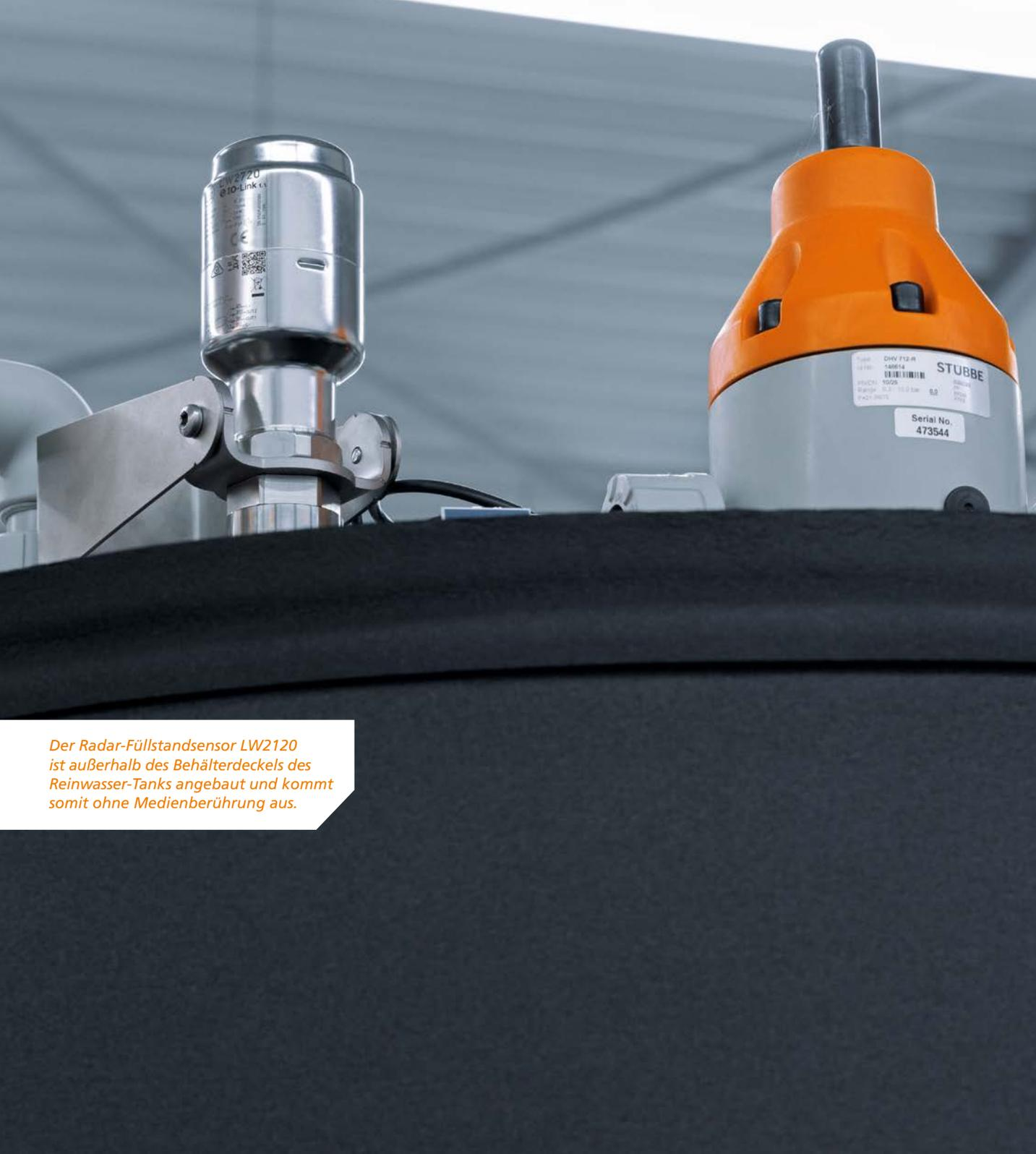
Der Radar-Füllstandsensor LW2120 ist außerhalb des Behälterdeckels des Reinwasser-Tanks angebaut und kommt somit ohne Medienberührung aus.
