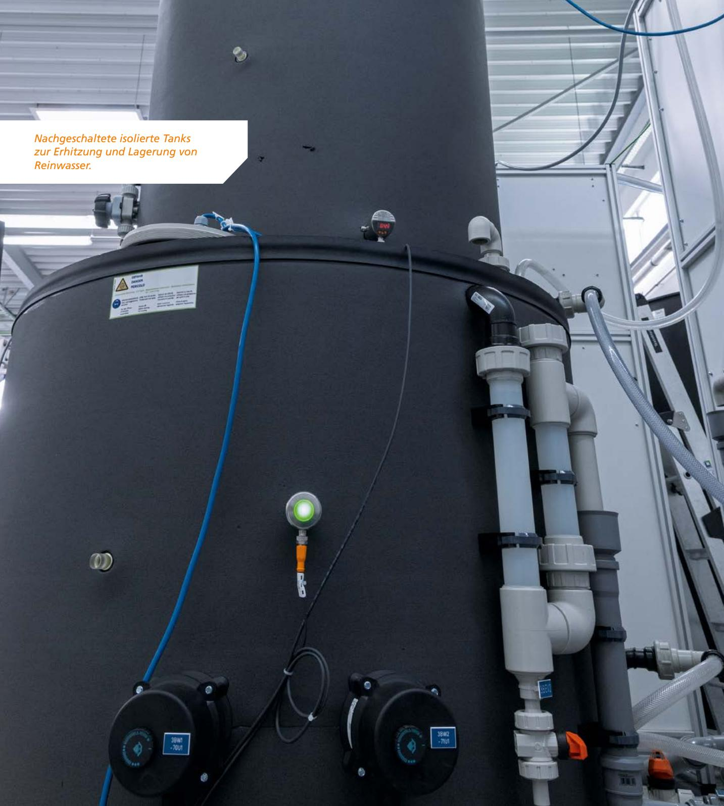
Nachgeschaltete isolierte Tanks zur Erhitzung und Lagerung von Reinwasser.
