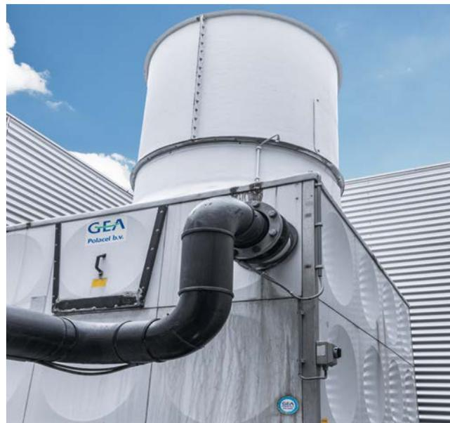
**Um zu verhindern, dass ggfs. mit Legionellen belasteter Wasserdampf in die Umgebungsluft gelangt, setzt das Krankenhaus „Spaarne Gasthuis“ bei Amsterdam HW Bifipro® Cool in seinem Kühlsystem ein.**
