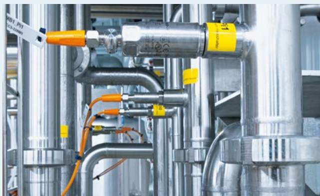
コンパクトで衛生的：セラミック測定セルのPM15シリーズ圧力センサ
