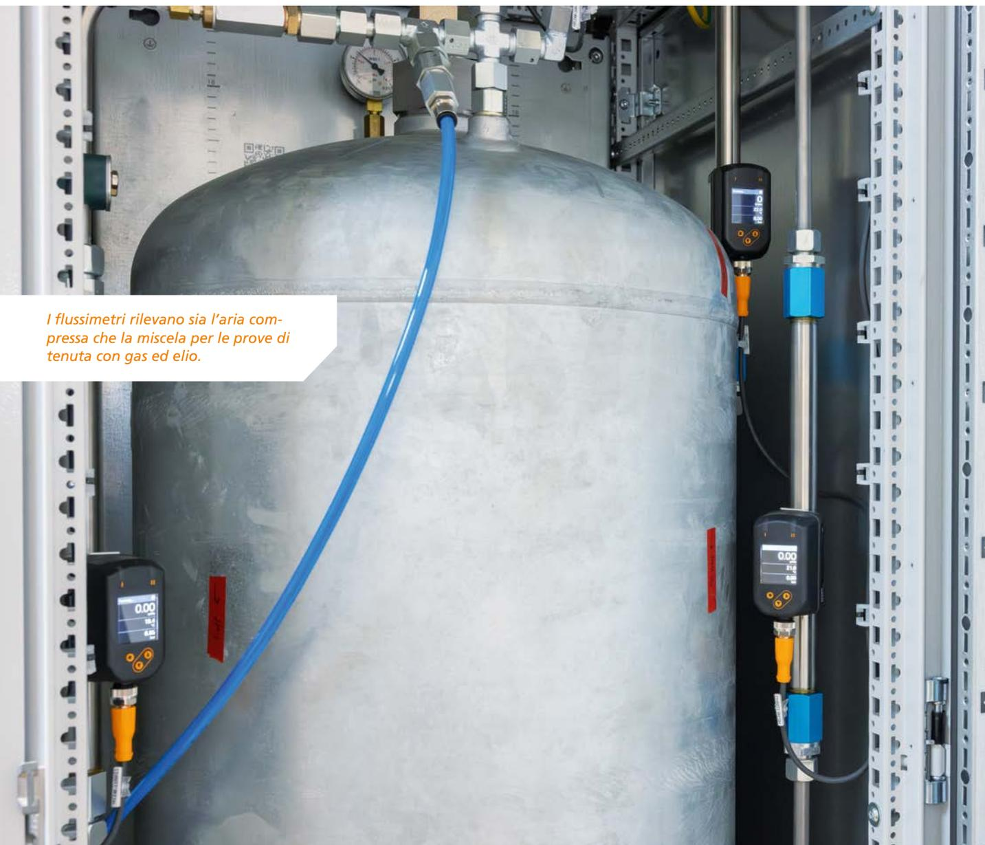
*I flussimetri rilevano sia l'aria compressa che la miscela per le prove di tenuta con gas ed elio.*
