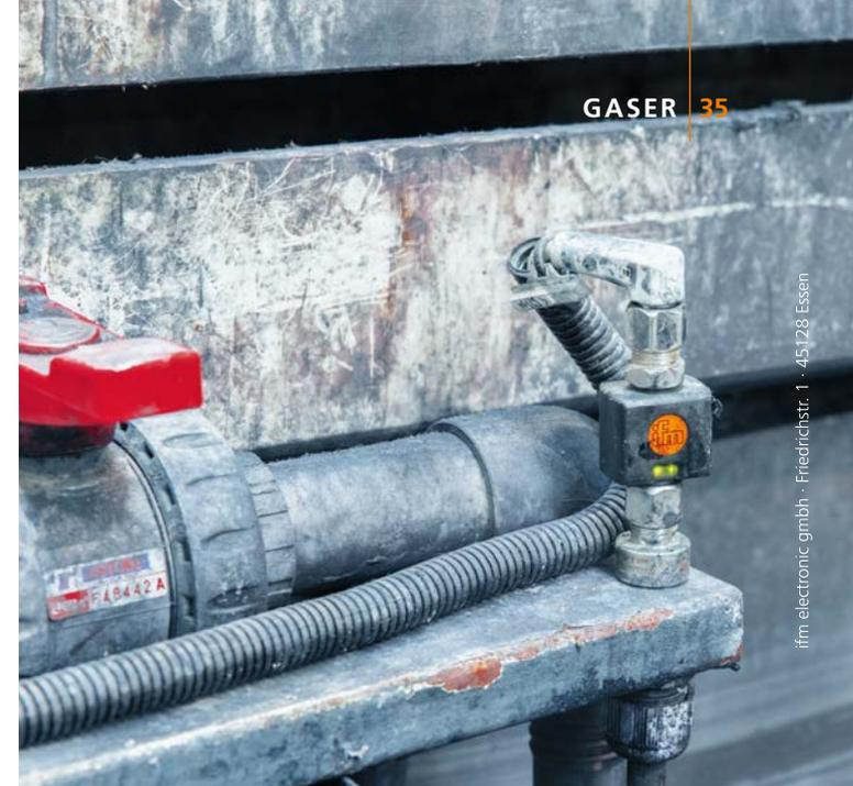
*La sonda di temperatura, l'amplificatore di controllo e il cavo sono resistenti nelle difficili condizioni ambientali del processo di anodizzazione.*
