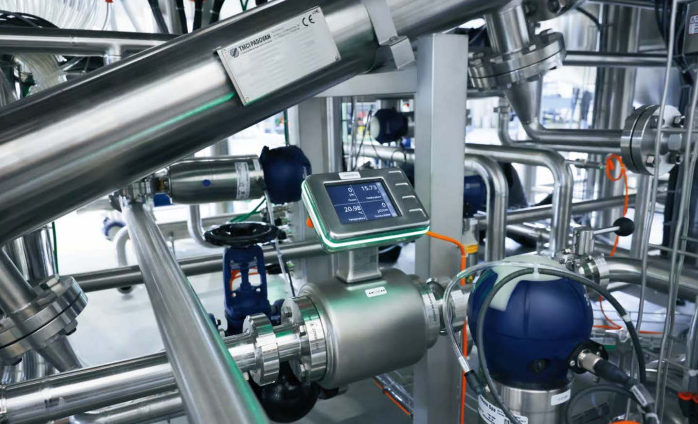
O SM Foodmag mede três parâmetros importantes em um ponto de medição: vazão, condutividade e temperatura.
