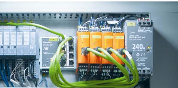
*Le boîtier électronique dans l'armoire électrique traite les données des capteurs de vibrations et transmet les résultats par Ethernet à la passerelle, le contrôleur IIoT d'ifm.*
