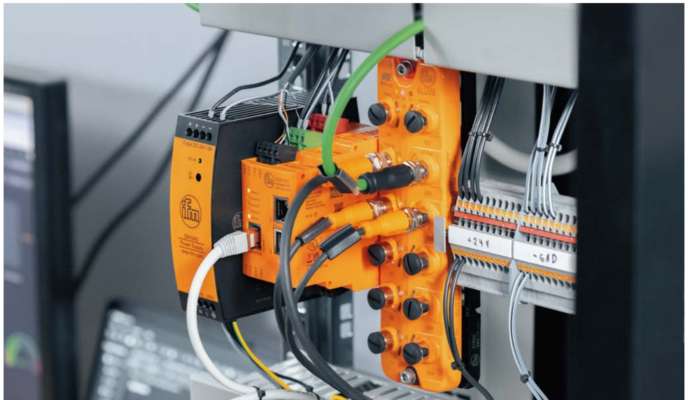
Alimentatore, centralina diagnostica e master IO-Link nel quadro elettrico dell'impianto.
