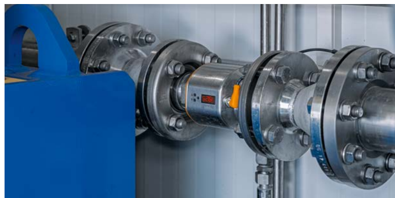
아날로그 측정값: 자기-유도형 유량 센서는 원심분리기에 들어가는 하수 슬러지의 양을 모니터링합니다.
