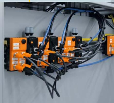
*AirBox AS-i viene utilizzato per la combinazione efficiente del modulo I/O e dell'elettrovalvola in sistemi pneumatici. I cilindri e le valvole o slitte, azionate da attuatori, vengono controllati in modo decentralizzato.*
