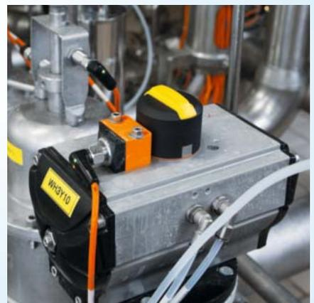
*Le robuste camme possono essere installate direttamente sull'albero dell'attuatore. Diversi diametri e ingombri in altezza consentono un adattamento perfetto all'azionamento corrispondente.*
