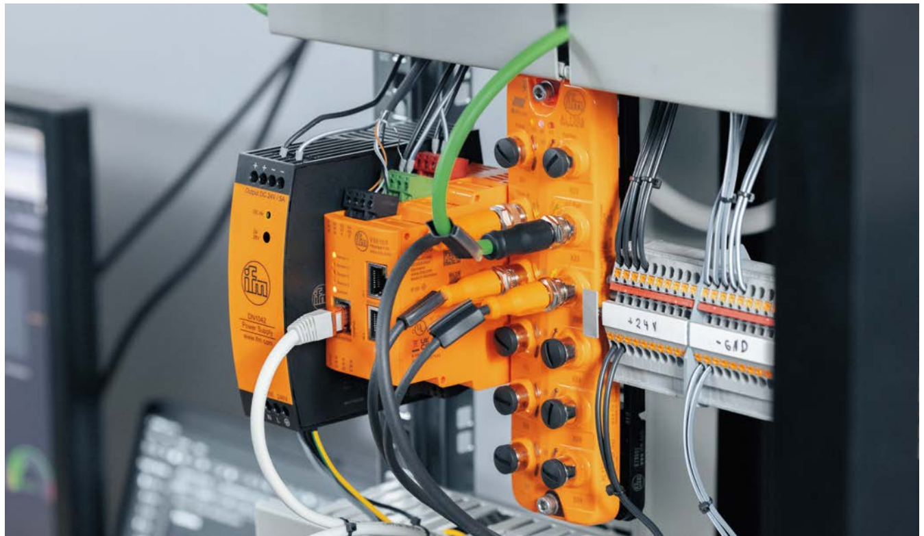
Netzteil, Schwingungsdiagnose- Auswerteeinheit und IO-Link-Master im Schaltschrank der Anlage.
