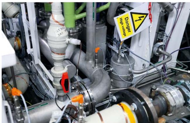
*Il monitoraggio preciso e continuo dei valori di pressione, livello e temperatura è necessario per garantire un funzionamento efficiente del sistema di propulsione a idrogeno.*
