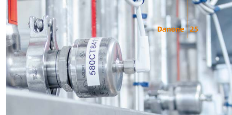
LDL200 導電率感測器可確保正確高效地執行 CIP 流程。
