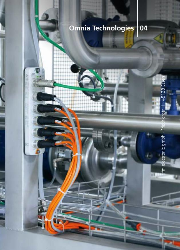
la longitud total de cables se reduce considerablemente y la conexión estándar M12 garantiza una conexión sin errores de los sensores y los maestros.
