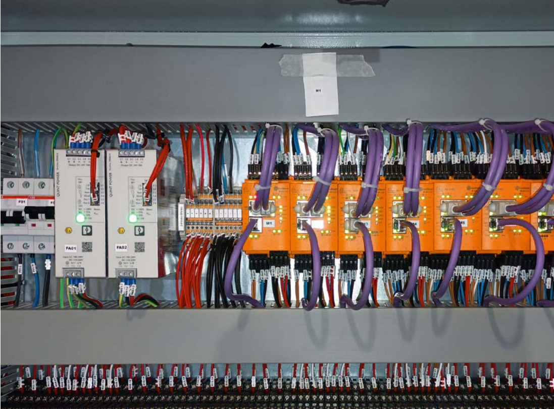
IO-Link-Master und Auswerteeinheiten für Schwingungssensorik sammeln die Daten ein und reichen sie gebündelt an die IT-Ebene weiter.
