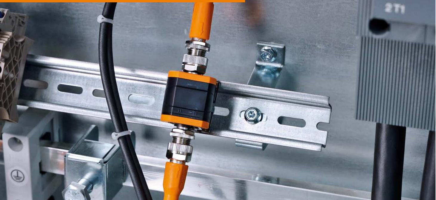
Sensoren, die noch nicht über IO-Link verfügen, können per Datensplitter dennoch in die IT-Struktur eingebunden werden.
