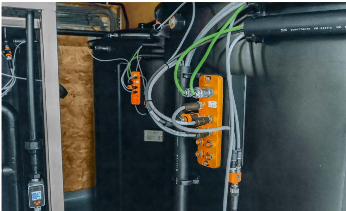
IO-Linkマスタがセンサの信号を一括収集してコントローラとITレベルに伝送します。マスタはデジチェーン接続で省配線化できます。
