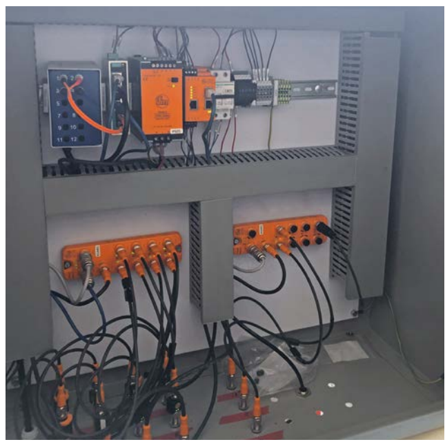
IO-Link를 사용하면 필요한 케이블 수와 공간이 줄어듭니다. Midvaal Water는 설치시간을 80% 단축할 수 있었습니다.
