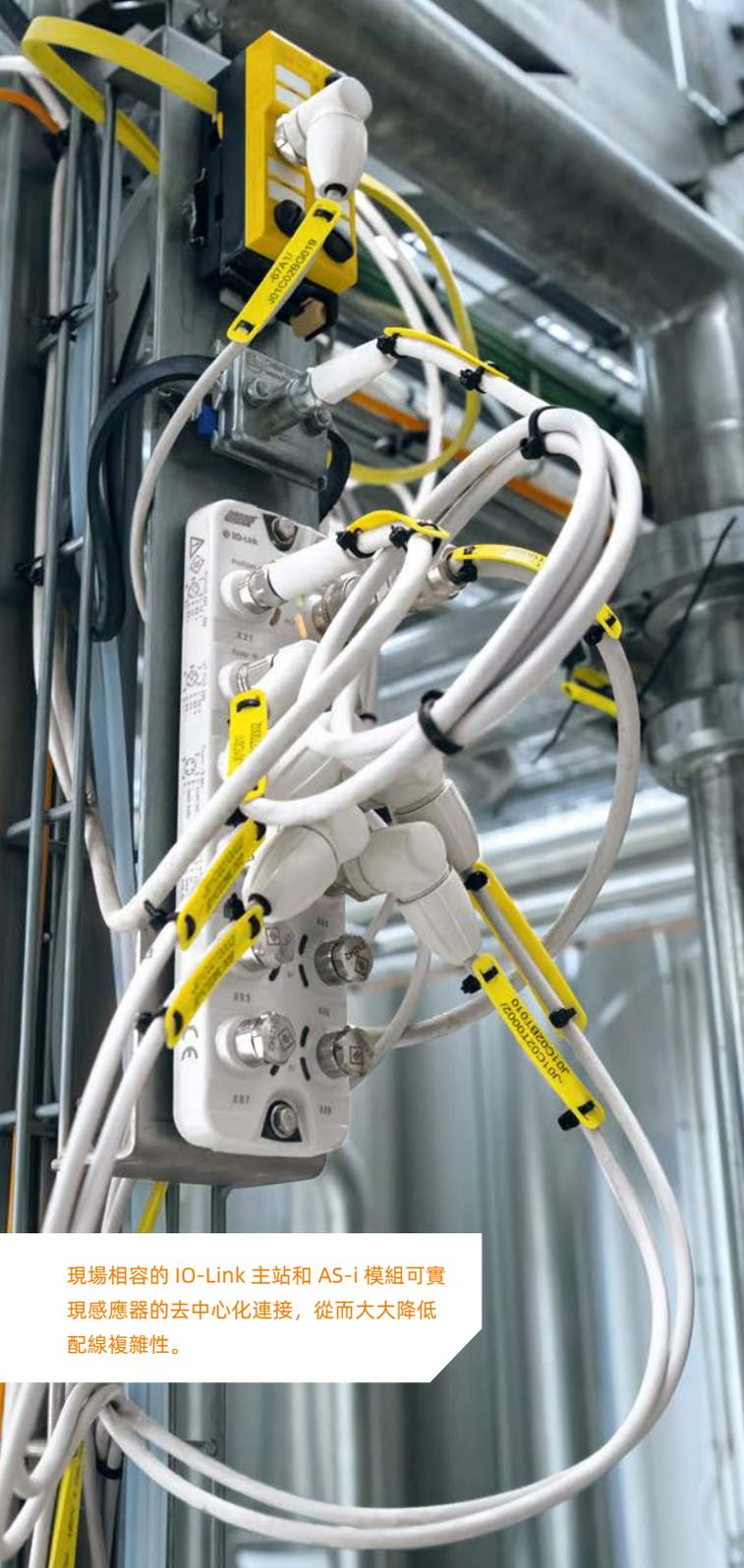
現場相容的 IO-Link 主站和 AS-i 模組可實現感應器的去中心化連接，從而大大降低配線複雜性。
