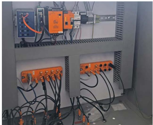
Die neue Verdrahtungsstruktur, die weitestgehend auf IO-Link basiert, benötigt erheblich weniger Platz und Verbindungstechnik, die Installationszeit konnte um 80 Prozent reduziert werden.
