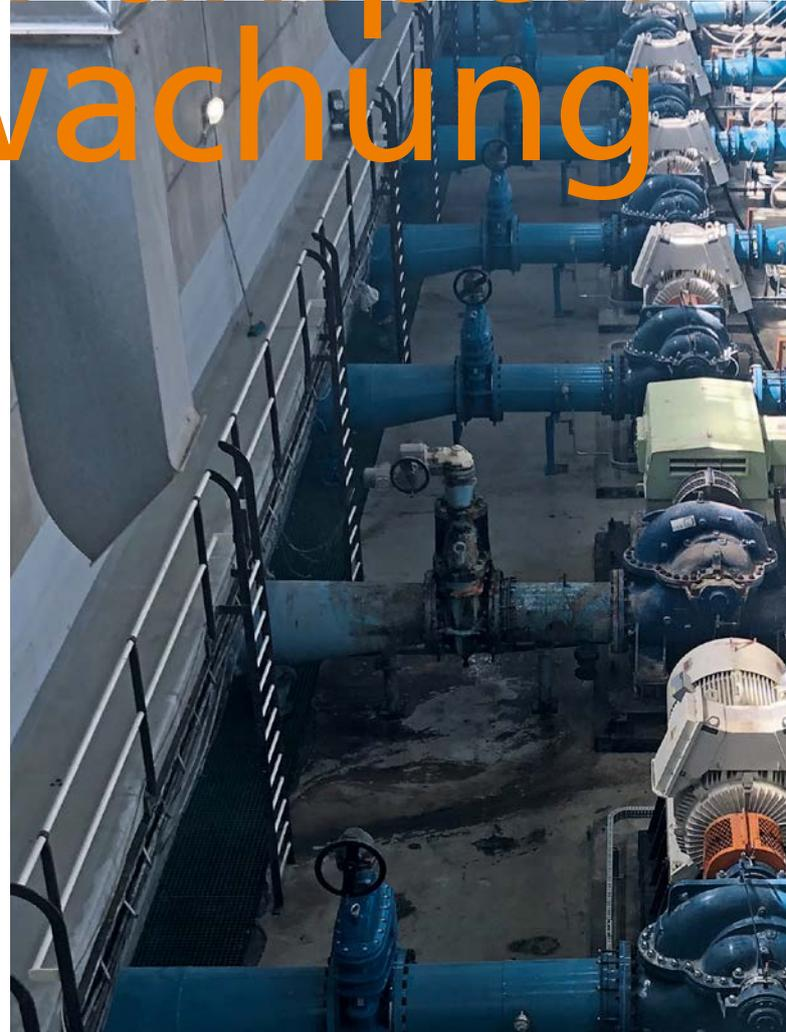
*Die High-Lift-Pumpstation von Midvaal Water. Die fünf neueren Motor-Pumpe-Einheiten (graues Motorgehäuse) wurden mit IO-Link-Sensoren und Condition-Monitoring-Lösungen ausgestattet.*
