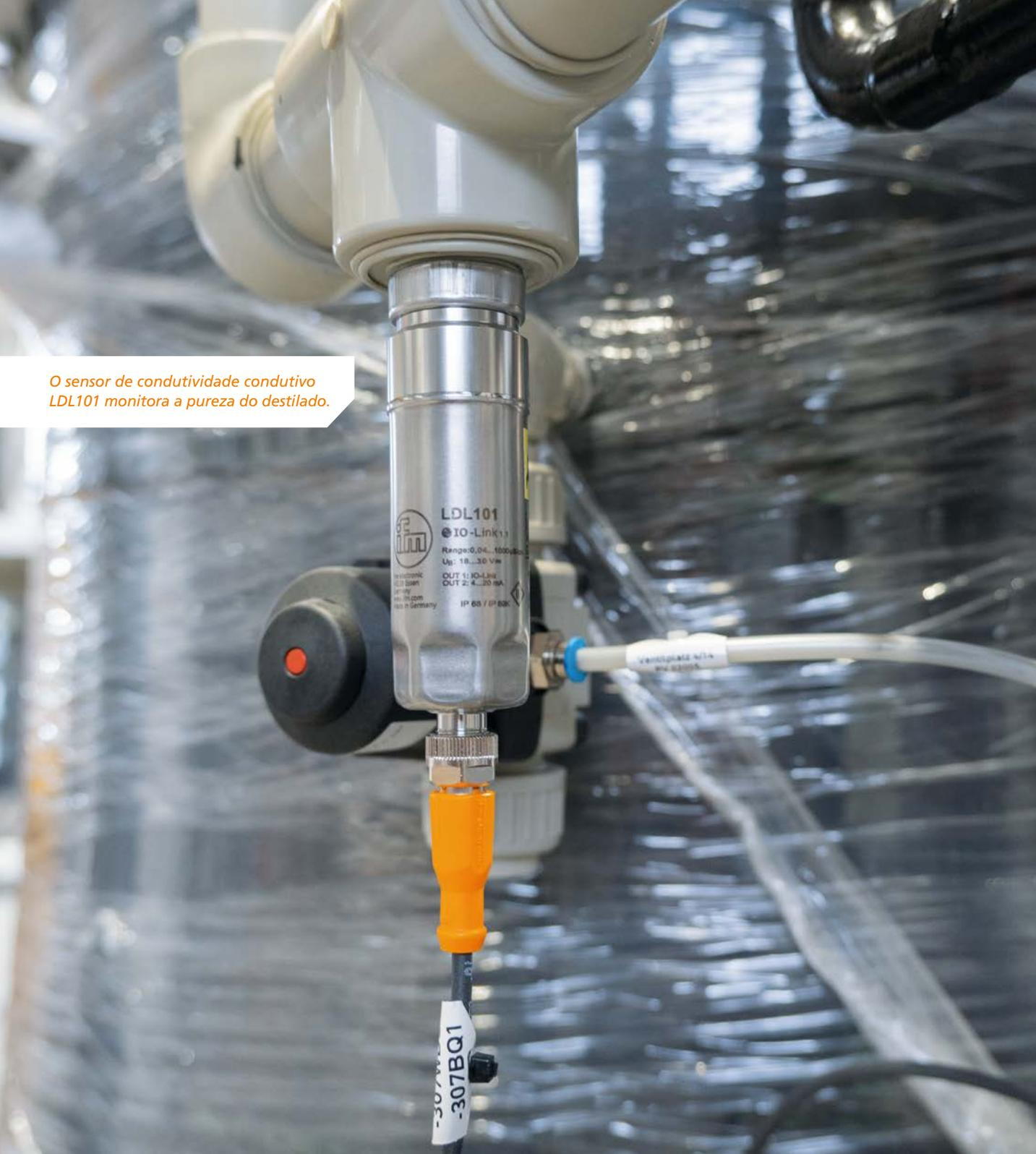
O sensor de condutividade condutivo LDL101 monitora a pureza do destilado.
