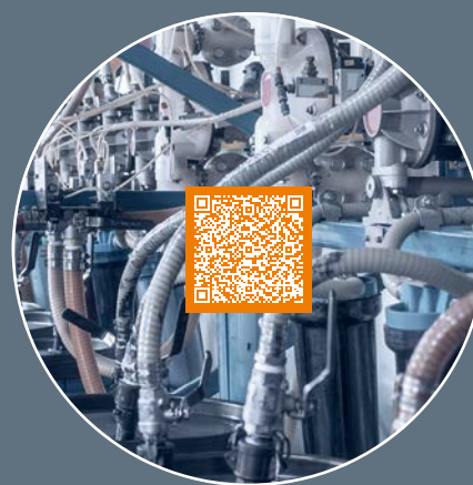
monec|RTM: Optymalizacja monitorowania poziomu w instalacji do kalibracji.
