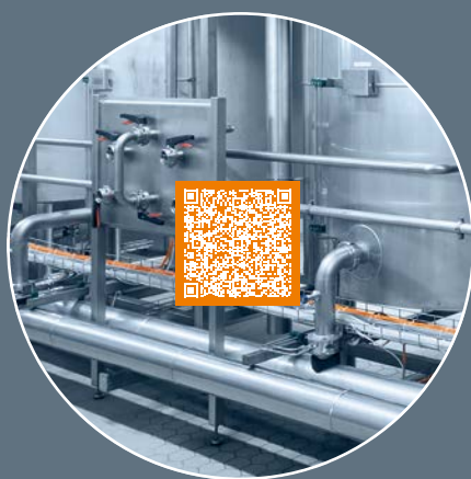
monec|RTM: Monitorowanie poziomu w zbiornikach z dwuskładnikową żywicą utwardzalną.
