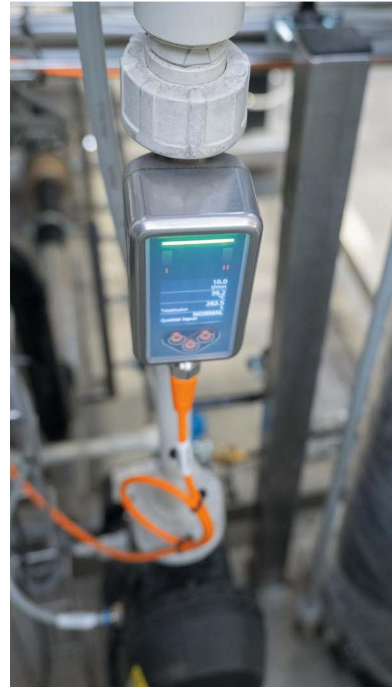
*Sämtliche Sensoren sind per IO-Link angeschlossen. Das verkürzt die Inbetriebnahme, vereinfacht die Parametrierung und erlaubt die Ferndiagnose bis in den Sensor hinein.*
