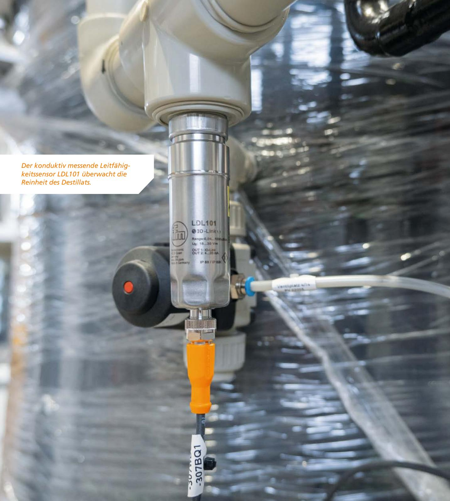
Der konduktiv messende Leitfähigkeitssensor LDL101 überwacht die Reinheit des Destillats.
