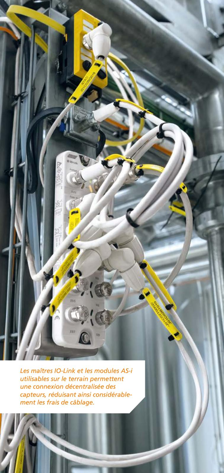
Les maîtres IO-Link et les modules AS-i utilisables sur le terrain permettent une connexion décentralisée des capteurs, réduisant ainsi considérablement les frais de câblage.
