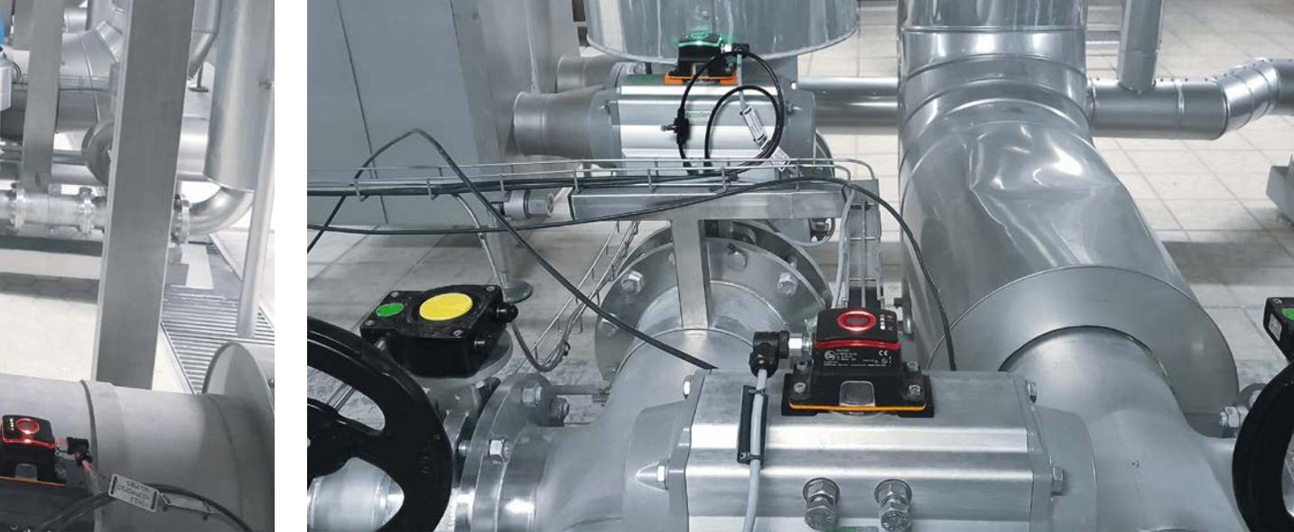
Veltins 的加熱和冷卻系統中已有約 40 個 MVQ。資料透過數位 IO-Link 通訊或模擬傳輸。
