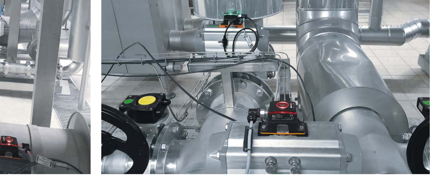
Veltins的供热和制冷系统中已安装了约40个MVQ传感器。其数据通过数字IO-Link通信或模拟信号传输。
