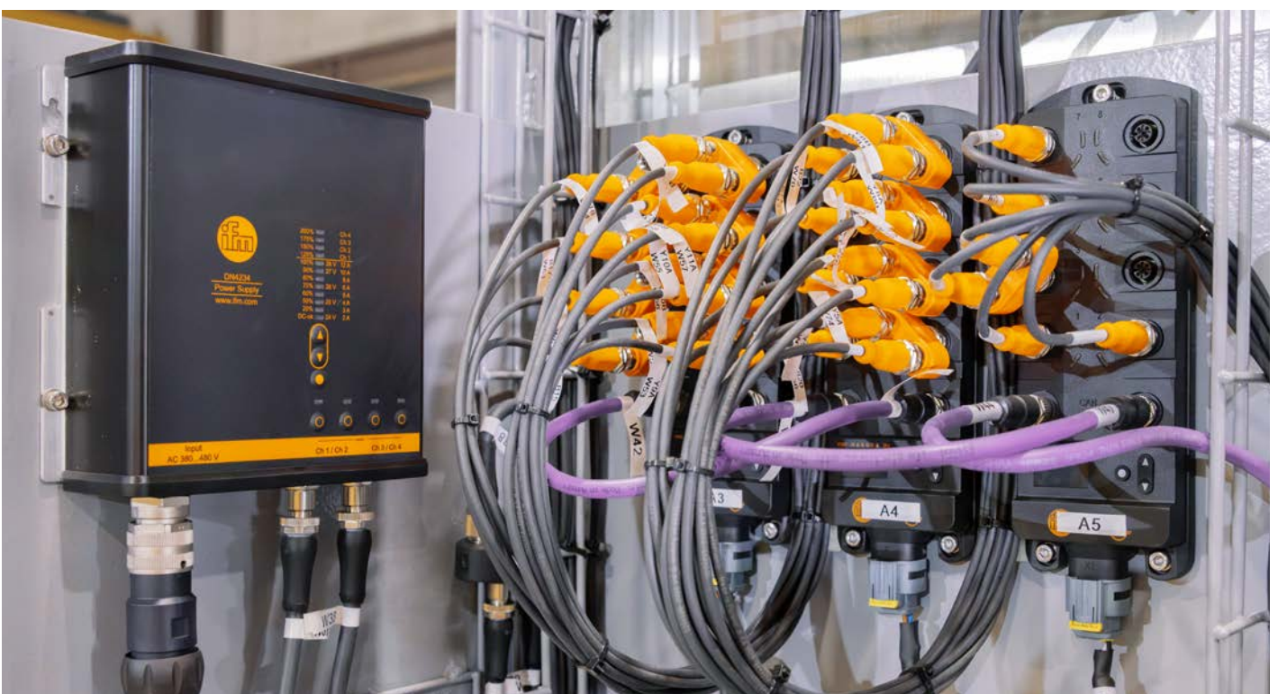
Die E/A-Module übernehmen die Datenerfassung vor Ort und vernetzen Sensoren und Aktuatoren mit der Maschinensteuerung.
