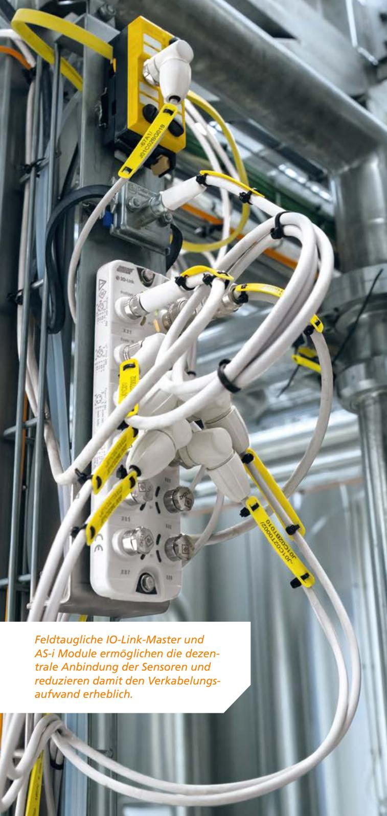
Feldtaugliche IO-Link-Master und AS-i Module ermöglichen die dezentrale Anbindung der Sensoren und reduzieren damit den Verkabelungsaufwand erheblich.
