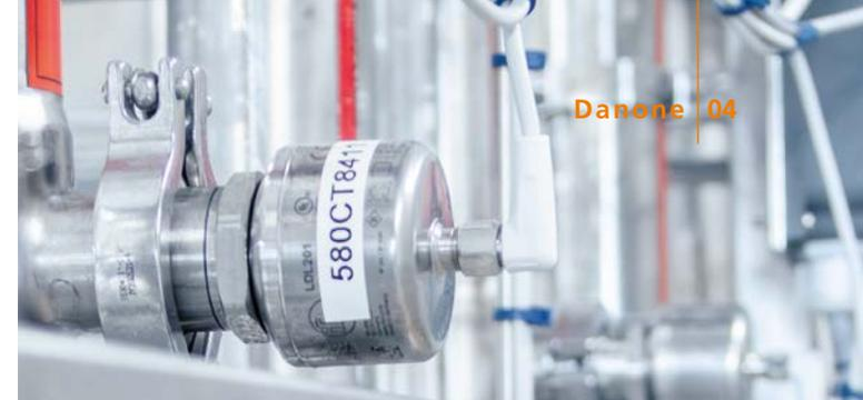
*Le capteur de conductivité LDL200 assure le déroulement correct et fiable du processus NEP.*
