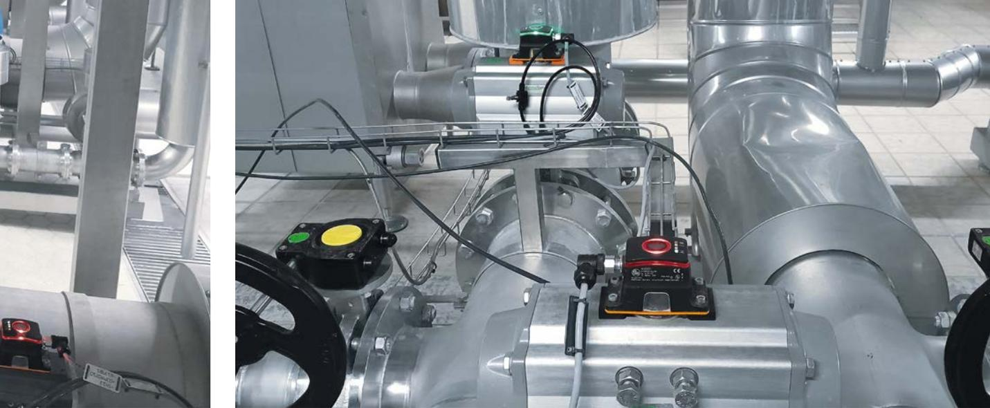
*Quelque 40 MVQ sont d'ores et déjà en service chez Veltins dans ses circuits d'eau de chauffage et de refroidissement. La transmission des données s'effectue pour certains via la communication IO-Link numérique et pour d'autres en analogique.*
