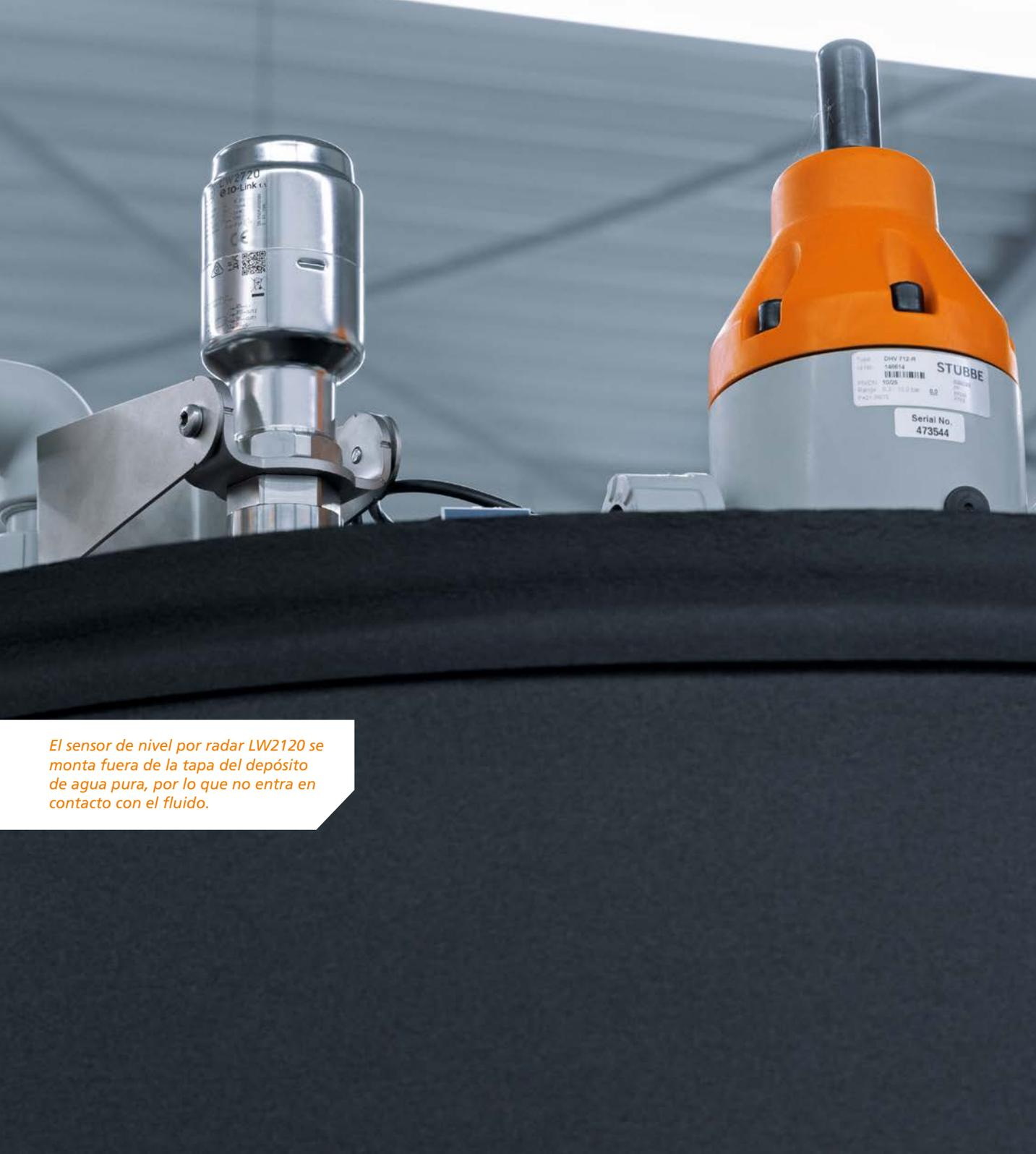
*El sensor de nivel por radar LW2120 se monta fuera de la tapa del depósito de agua pura, por lo que no entra en contacto con el fluido.*
