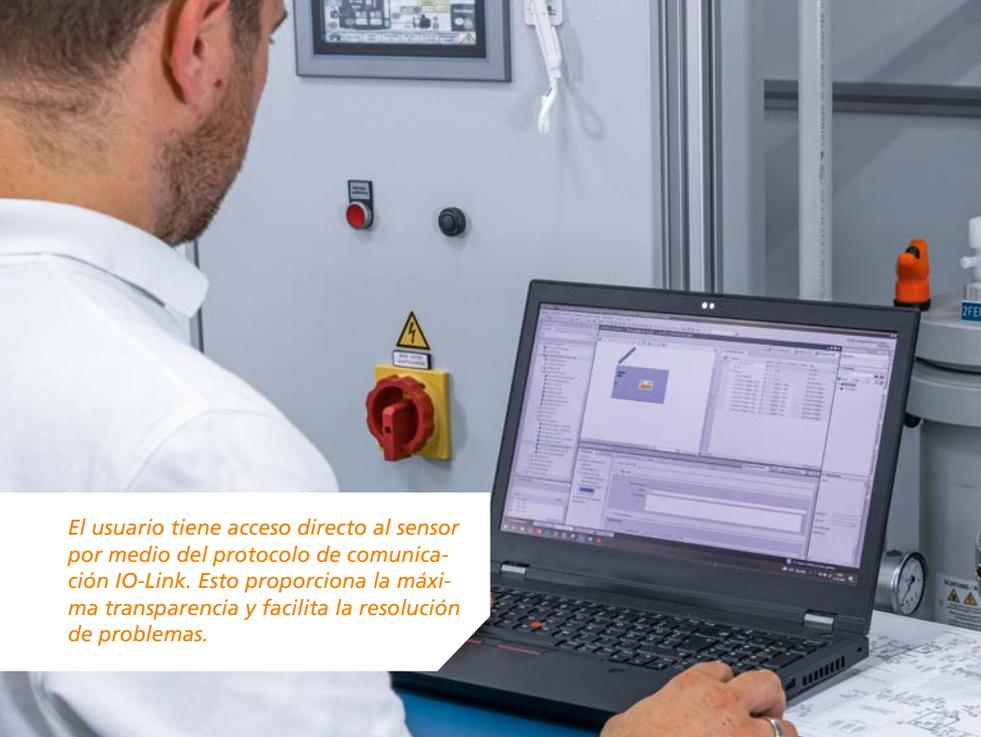
*El usuario tiene acceso directo al sensor por medio del protocolo de comunicación IO-Link. Esto proporciona la máxima transparencia y facilita la resolución de problemas.*
