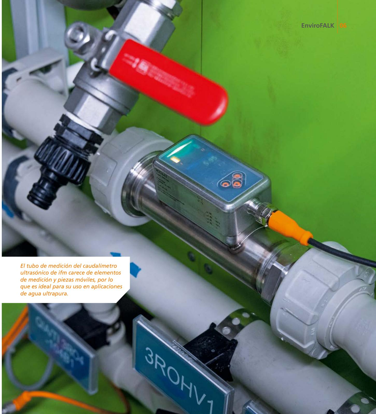
*El tubo de medición del caudalímetro ultrasónico de ifm carece de elementos de medición y piezas móviles, por lo que es ideal para su uso en aplicaciones de agua ultrapura.*
