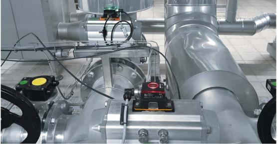
Rund 40 MVO hat Veltins in seinen Heiz- und Kühlwasserkreisläufen bereits im Einsatz. Die Datenübermittlung erfolgt teils per digitaler IO-Link-Kommunikation, teils im Analog-Modus.
