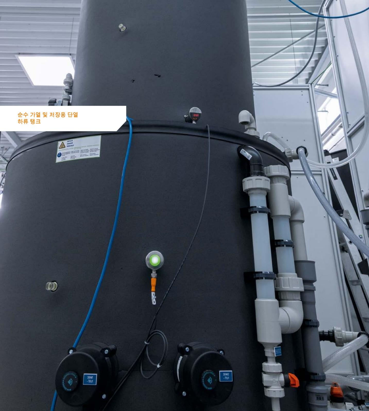
광물이 제거된 물이 주위 물질(예: 기존 스텐레스 벽면)에 있는 광물을 용해하여 비자연적인 탈염 상태를 계속 보정하려고 하는 또다른 문제가 있는데, 이 문제 때문에 시간이 지나면 점식이 발생할 수 있습니다. 그래서 이 시스템의 파이프는 품질이 특히 높은 플라스틱이나 스텐레스로 제작됩니다. 매질과 접촉하는 센서도 마찬가지입니다. ifm은 초순수 용도를 위한 특수 센서를 제공합니다. 감지면의 접촉부는 초순수가 분자를 추출할 수 없는 고급 스텐레스나 기타 물질로 구성됩니다.
