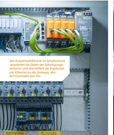
Der IloT-Controller übermittelt sämtliche Sensordaten an die höhergelegene IT-Ebene, wo sie für den Kunden von EREMA sowohl am Laptop als auch per Smartphone jederzeit abrufbar sind. **J** Bei ifm erhalten wir vom Sensor über die Auswerteelektronik, *IO-Link-Master und das Gateway* alles aus einer Hand.
