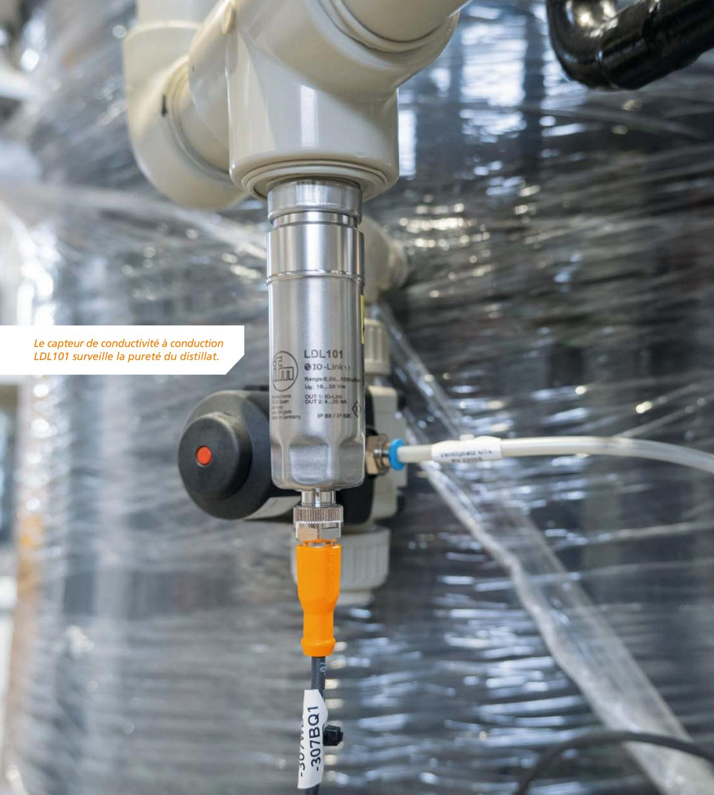
*Le capteur de conductivité à conduction LDL101 surveille la pureté du distillat.*
