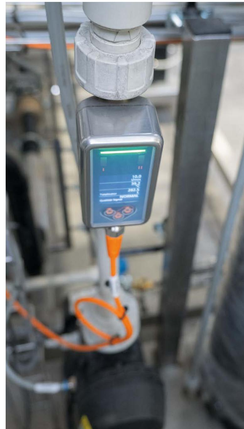
*Tous les capteurs sont raccordés via IO-Link. Cela raccourcit la mise en service, simplifie le paramétrage et permet le télédiagnostic jusqu'au capteur.*
