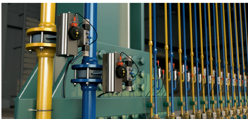
雙感應面電感式感應器，應用於氣動閥門驅動裝置的位置反饋
