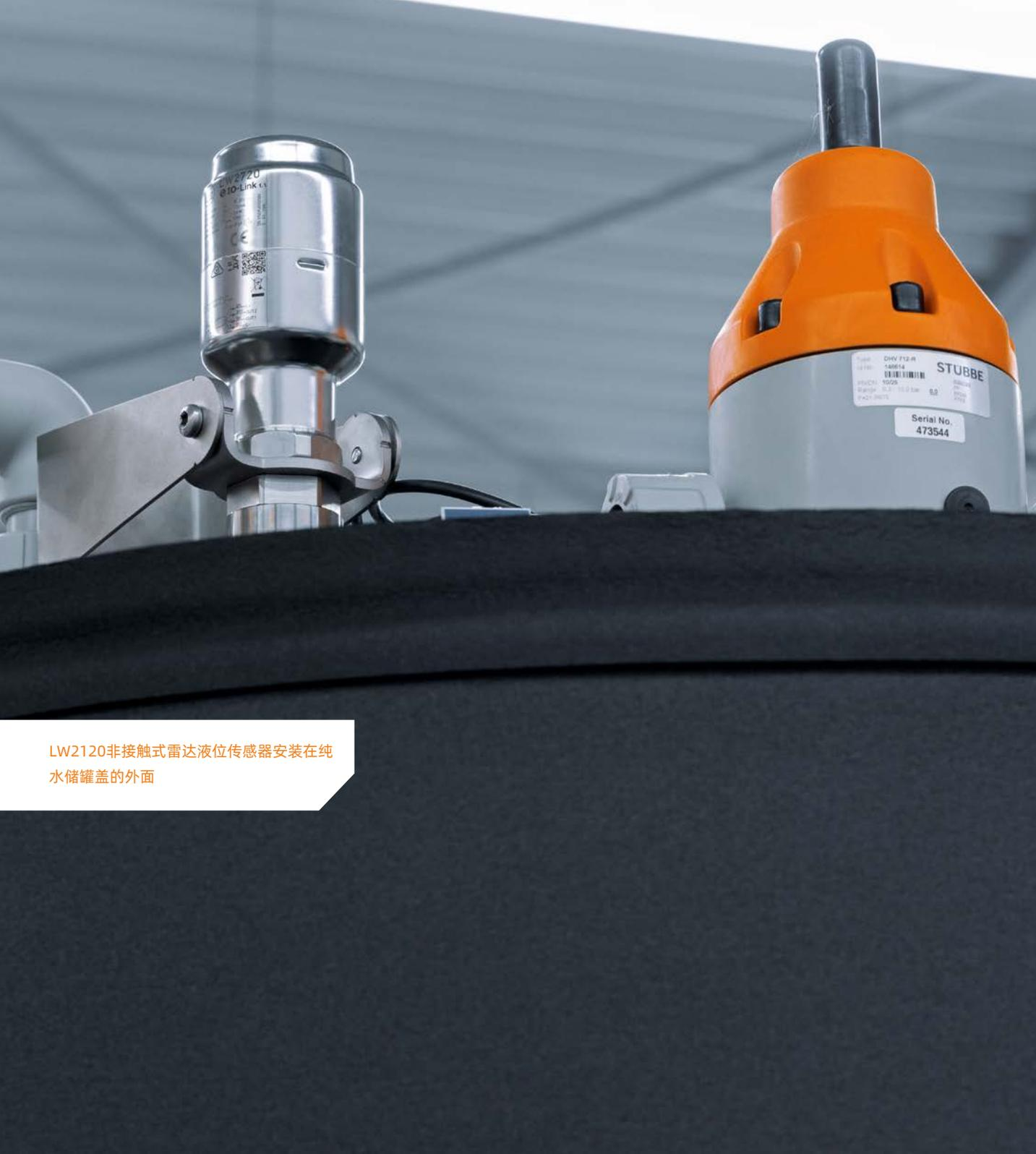
LW2120非接触式雷达液位传感器安装在纯水储罐盖的外面
