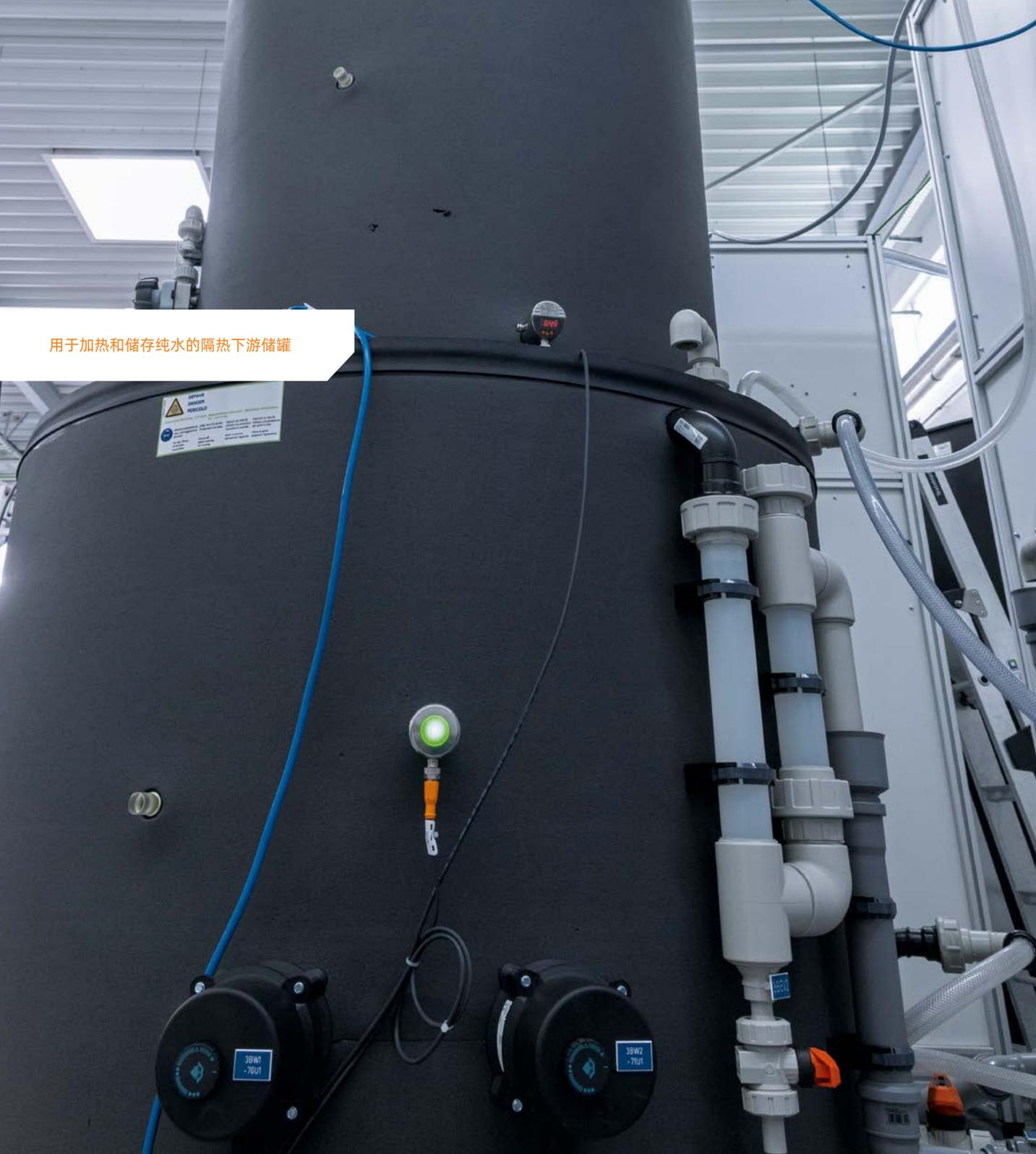
用于加热和储存纯水的隔热下游储罐
